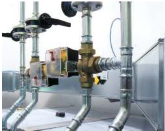
Рис. 22. steelPRES — контур охлаждения.
